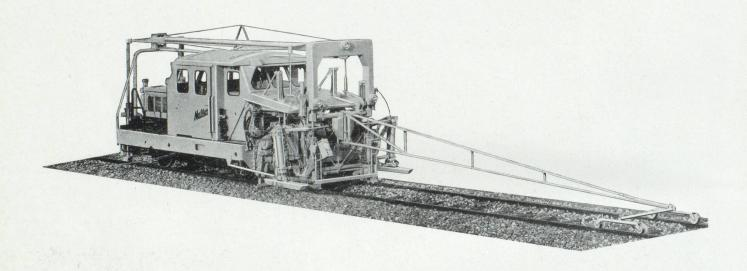
La Bourreuse-Niveleuse MATISA B-60, entièrement automatique, permet de bourrer et de niveler la voie simultanément, avec une précision de ±1 mm dans le profil longitudinal et transversal.
