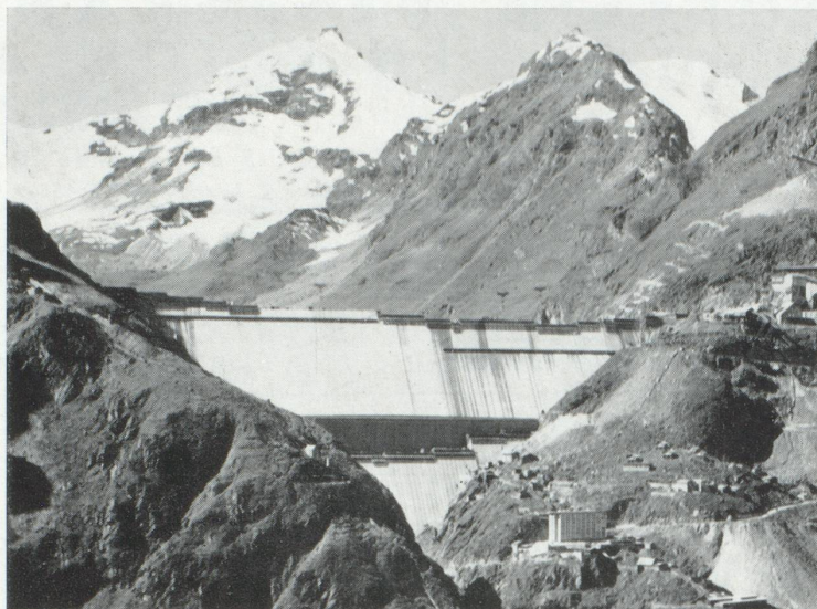
Barrage de la Grande-Dixence (en association)
