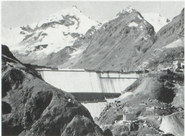
Barrage de la Grande-Dixence (en association)
