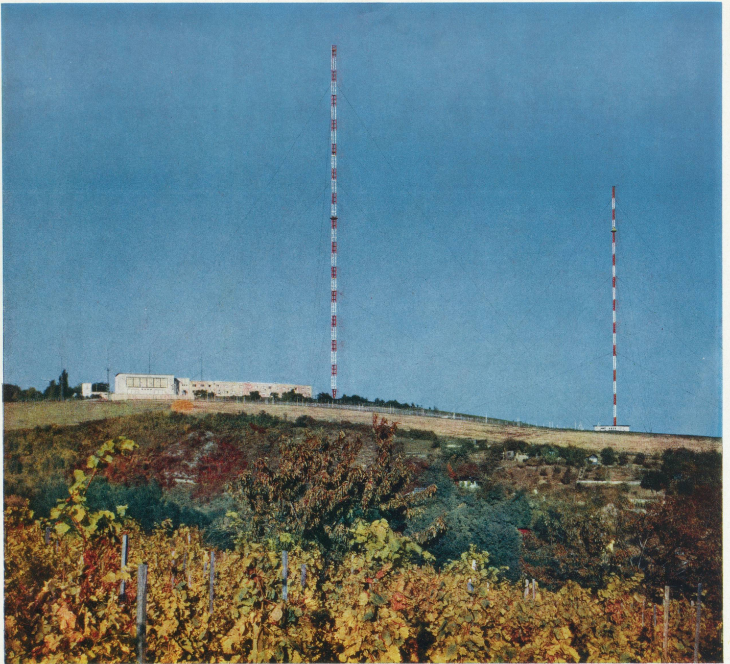
Le poste émetteur de Bisamberg, près de Vienne, est le plus grand poste émetteur d'Autriche. (Le pylône principal a 265 m de hauteur.) Il a été construit par Brown Boveri.
