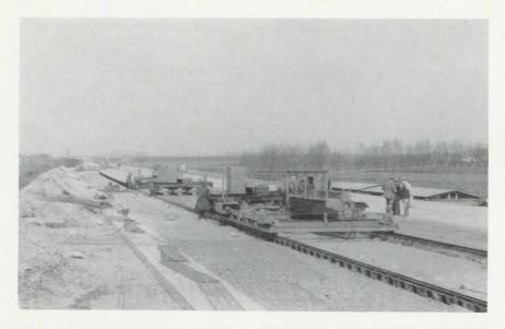
L'enrobé composé, soit d'un matériau tout venant, soit de deux agrégats, gravier et sable, permet le stockage en vrac, et la manipulation par poussage contre un bouclier, encadrant l'élévateur.
