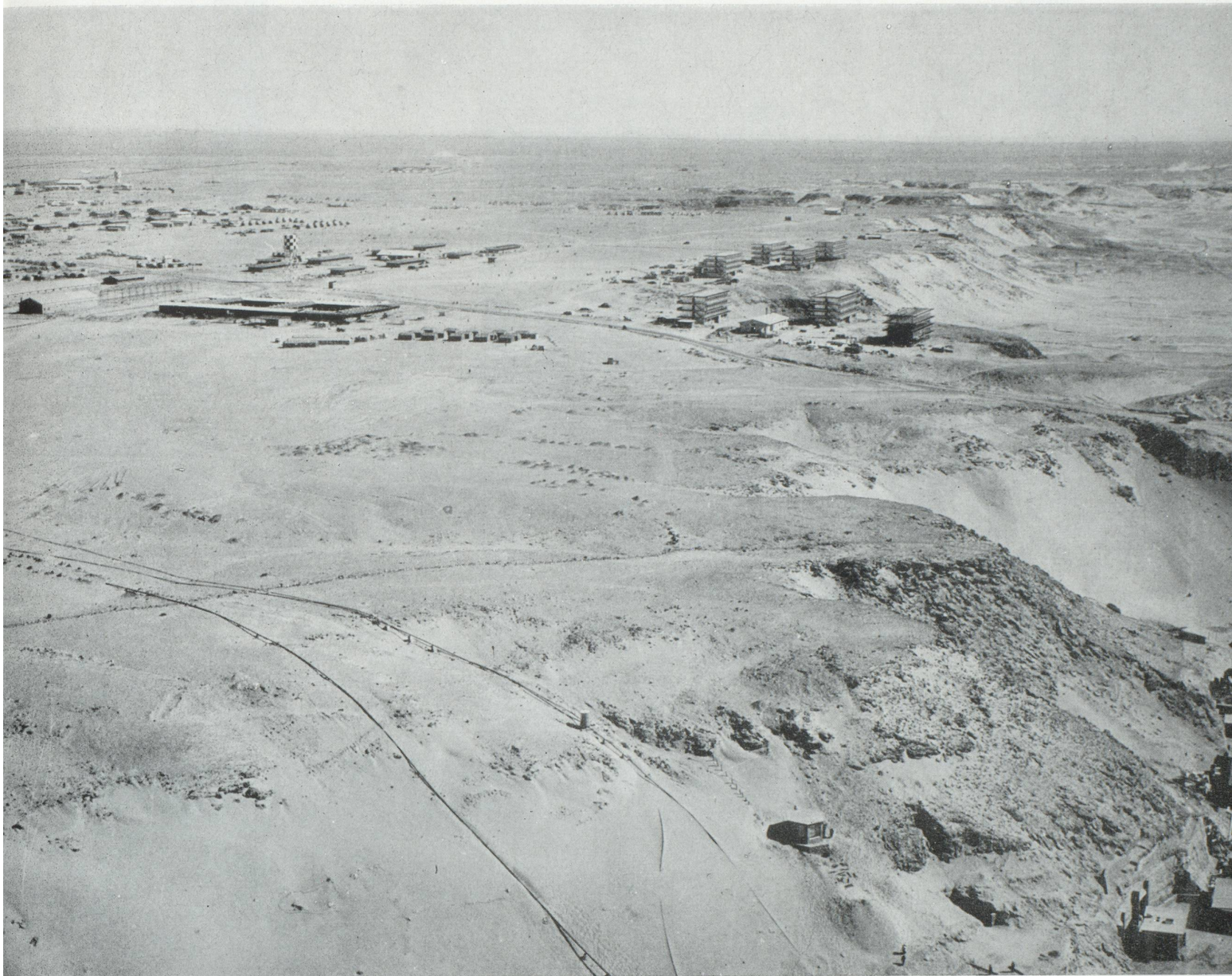
Reggan: vue générale (Photo S.C.A.)
