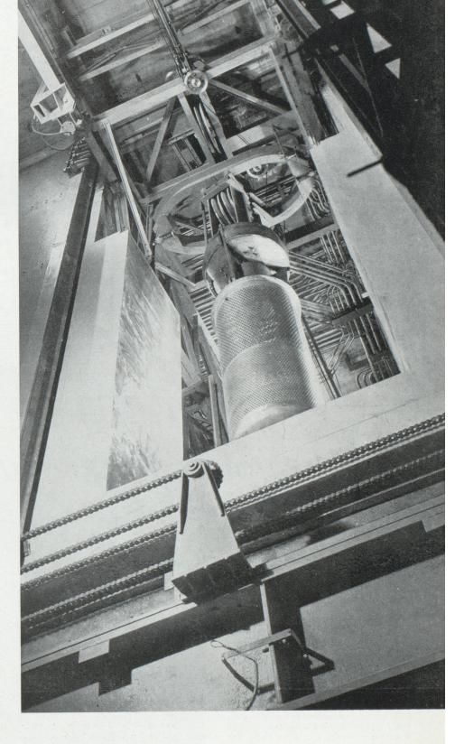
Panier d'uranium en traitement dans l'usine de plutonium de Marcoule, Entrée dans la salle de dissolution (Photos C.E.A.)
