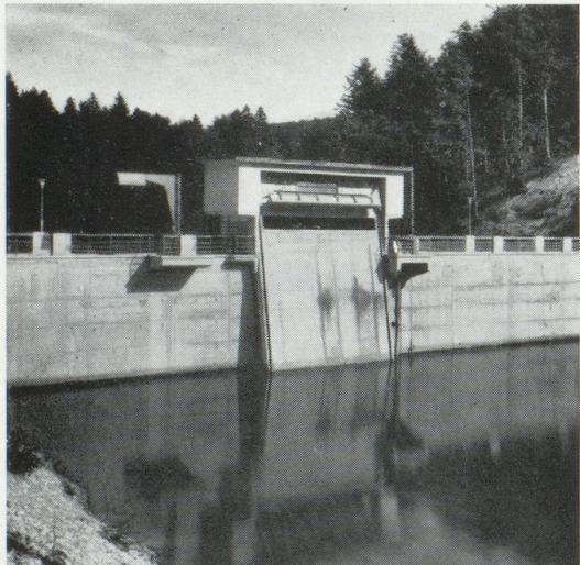
Appareils dégrilleurs automatiques et semi-automatiques pour prises d'eau de stations de pompage pour usines thermiques et autres.
