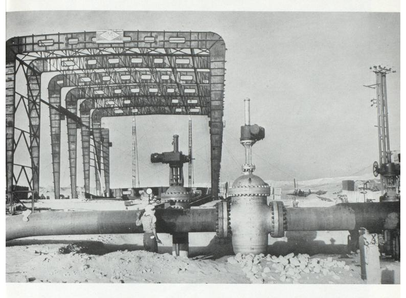
Haoud el Hamra. — Armature de la centrale électrique en construction. Au premier plan, élément de l'oléoduc Hassi Messaoud-Bougie (Cliché B. R. P.)
