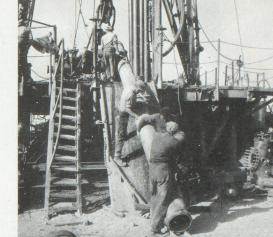
Préparation du matériel nécessaire à la descente d'un tubage (appareil de forage « Unit RIG I 5 » moyen (Cliché B. R. P.)
