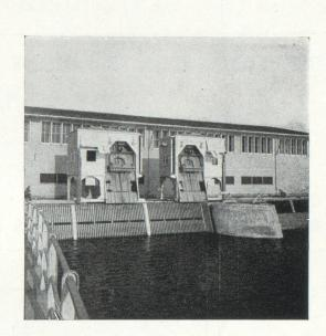
Pour chaque prise d'eau l'appareil dégrilleur approprié
