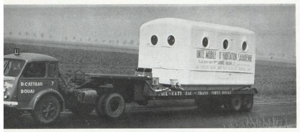
Transport d'une unité mobile d'habitation destinée au Sahara et fabriquée à Douai par la Société pour l'Application Industrielle des Résines de Synthèse. Les parois de cette coupole sont constituées d'une épaisseur de chlorure de polyvinyle cellulaire entre deux couches de stratifié verre-résine polyester norsodyne. Cette cabine susceptible d'assurer le logement de 2 à 4 personnes, a été spécialement conçue dans sa première version pour le logement
