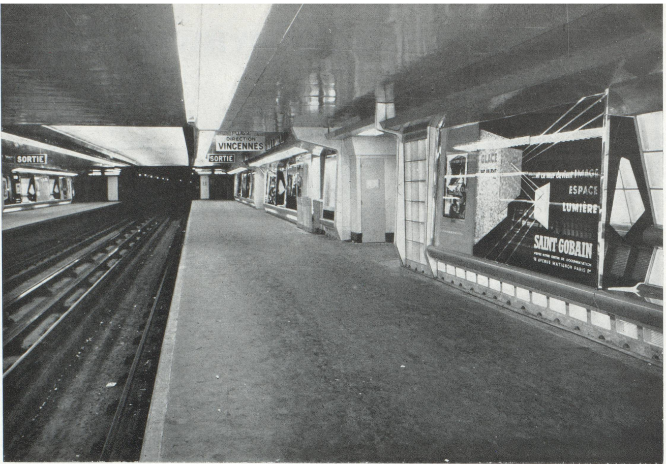
Installations d'une station du métropolitain réalisées en verre et en stratifiés polyesters. (Document Saint-Gobain; photo Pierre Grossman.)
