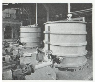
Installation de bassins et tuyauteries (remarquer la bande en Lucoflex transparent permettant la surveillance visuelle du niveau).
