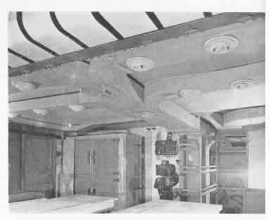
Installation de la ventilation en Lucoflex à bord du navire bananier « Fort Niagara ».
