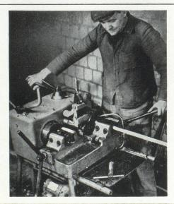
Appareils et Machines à fileter les tubes
