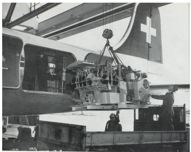
▲ Chargement d'une machine à empaqueter les biscuits, d'un poids de 2 150 kg, pour son transport par DC-4 de Swissair, de Zurich à Londres
