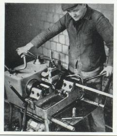
Appareils et Machines à fileter les tubes
