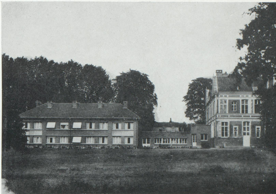
Maison de repos de Lompret de la Caisse d'allocations familiales de Lille. Hébergement des mamans.
