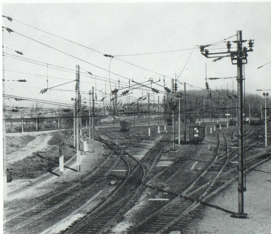
Photo n° 1 : La toile d'araignée des caténaires de la tête de faisceau d'un grand triage, côté formation.
