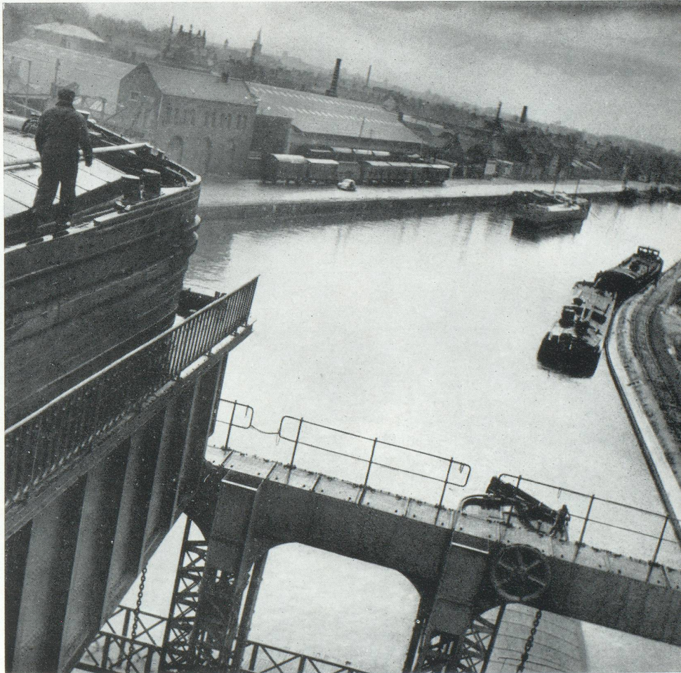
St-Omer : l'ascenseur des Fontenilles (canaux du Nord).
