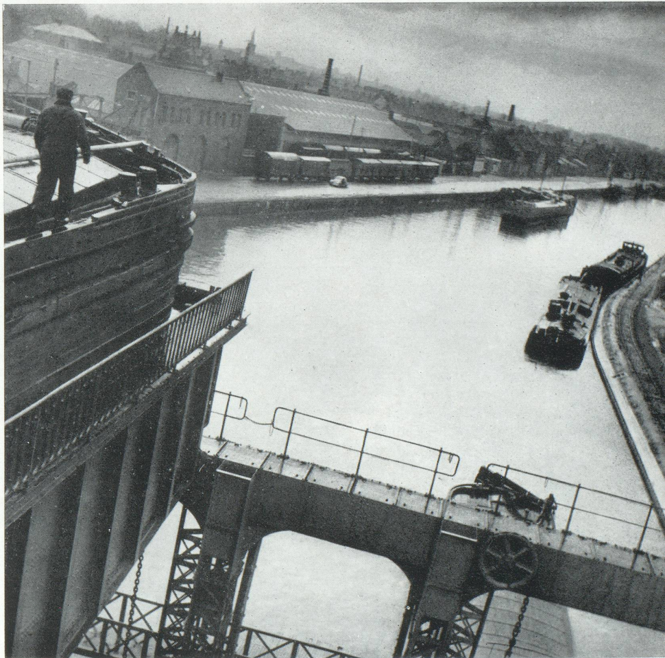
St-Omer : l'ascenseur des Fontenilles (canaux du Nord).
