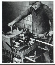
Appareils et Machines à fileter les tubes
