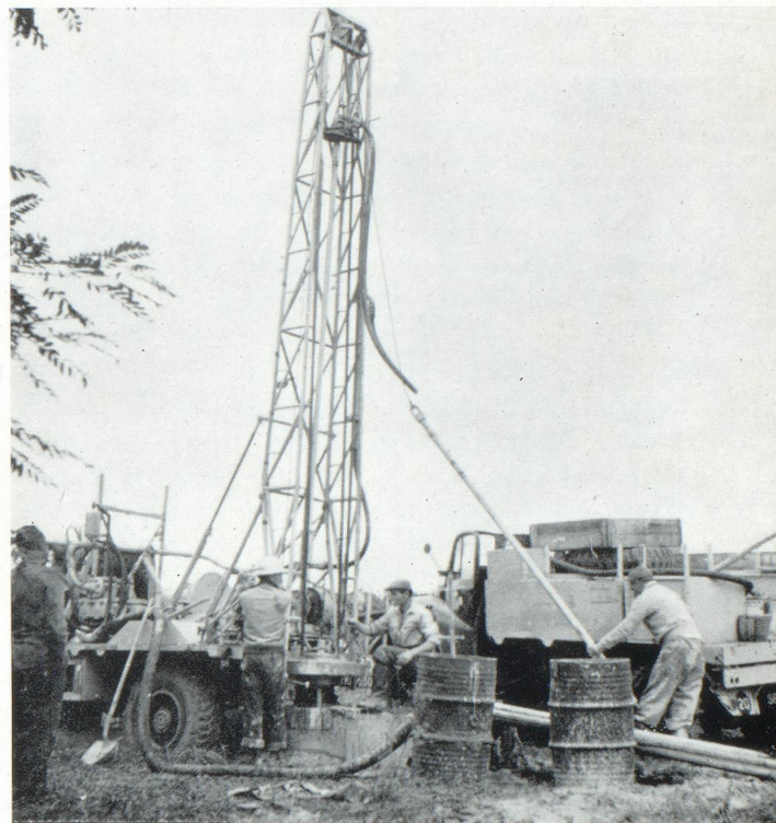
Forages pour des recherches sismiques dans le canton de Genève
