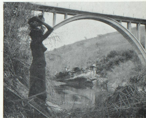
A. E. F. : Moyen- Congo. Chemin de fer Congo-Océan. Dans la vallée du Niari. Pont sur la Loutété (Photo- thèque du Ministère de la France d'Outre-Mer)
