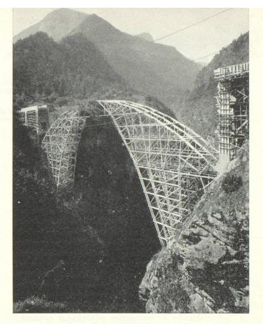
Charpente pour l'édification d'un pont sur les Gorges du Trient en Valais
