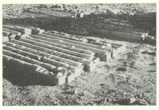
La construction d'un barrage nécessite des travaux de préparation considérables. Voici des carottes de sondages effectués à Djorf Torba, à l'ouest de Colomb-Béchar.
