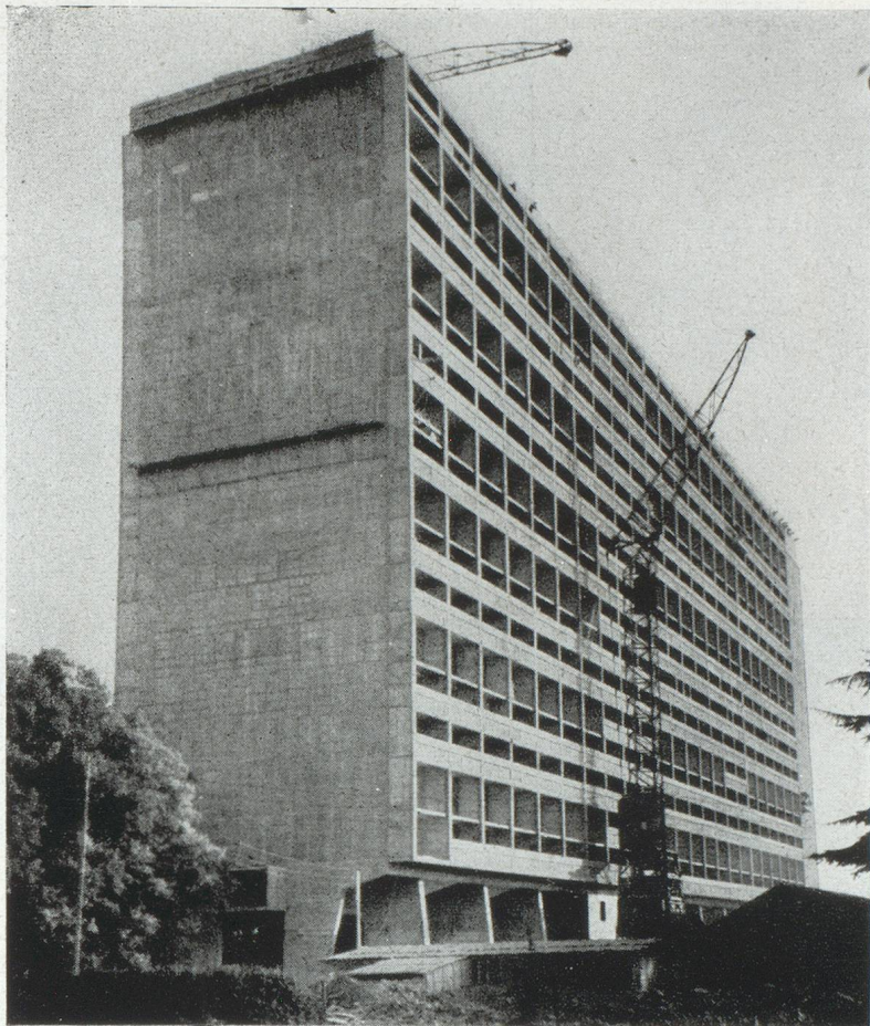
LE CORBUSIER : la Cité radieuse de Nantes actuellement en construction selon le même modèle que celle de Marseille.
