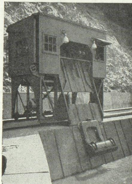
Râteaux mécaniques et appareils
