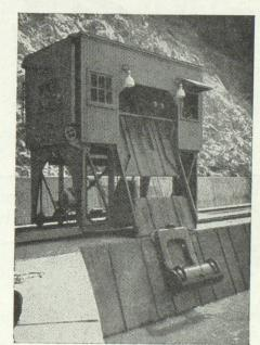
Râteaux mécaniques et appareils dégrilleurs pour usines hydro-électriques
