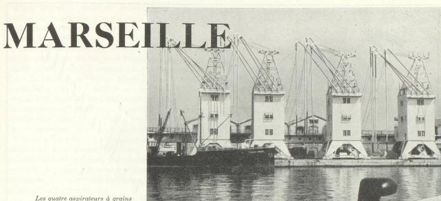
Les quatre aspirateurs à grains du port de Marseille, d'une puissance unitaire de 250 tonnes à l'heure
