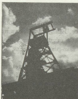
Siège 9/17 du groupe d'Hénin-Liétard des Houillères du bassin du Nord et du Pas-de-Calais. Chevalement du puits 17 ; ce chevalement, équipé de deux skips, permet l'extraction quotidienne de 3.500 tonnes net de charbon.
