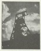
Siège 9/17 du groupe d'Hénin-Liétard des Houillères du bassin du Nord et du Pasde-Calais. Chevalement du puits 17; ce chevalement, équipé de deux skips, permet l'extraction quotidienne de 3.500 tonnes net de charbon.
