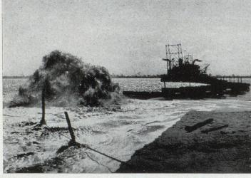
$Port\ d'Abidjan: refoulement\ des\ sables\ en\ terre-plein\ par\ conduite\ flottante\ (Société\ des\ dragages)$
