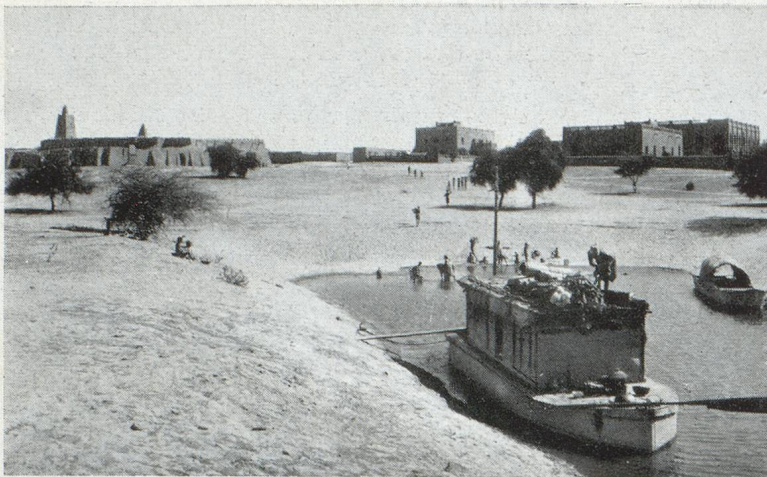
Le pont administratif de Tombouctou sur le canal Kabara (Niger-Soudan)
