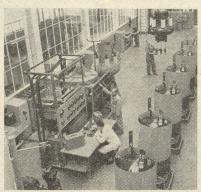
Six redresseurs mono-anodiques sans pompe à vide, formant un groupe de 3,600 A à 850 V dans l'un des balls de montage des Ateliers de Sécheron.
