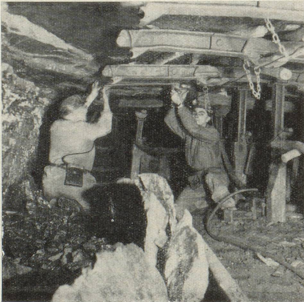
Posé de soutènements métalliques
