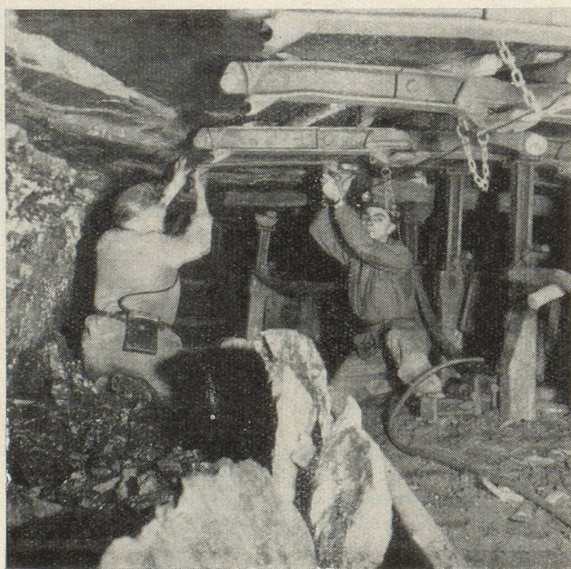
Posé de soutènements métalliques
