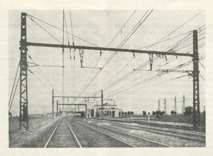
Section à quatre voies électrifiées entre Paris et Dijon. A droite, une sous-station.
