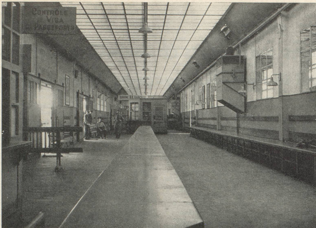
Genève Cornavin : installations de la douane et de la police suisses à la sortie de France. (Photo Wassermann, Genève).
