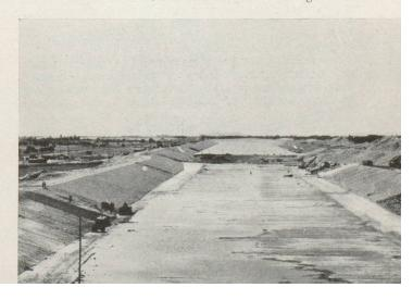
vagues des bateaux et contre le vent par des revêtements en béton bitumeux ou en ciment.
