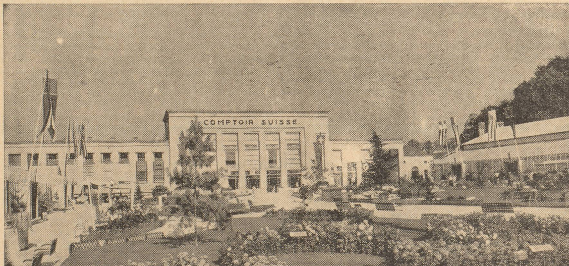
Vue du jardin et de la halle principale
