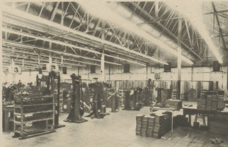
ECLAIRAGE PAR TUBES FLUORESCENTS D'UN ATELIER DE MECANIQUE. — L'atelier est entièrement dans la lumière. Les machines, aussi bien que les dégagements, sont bien éclairés. (Photo Philips.)
