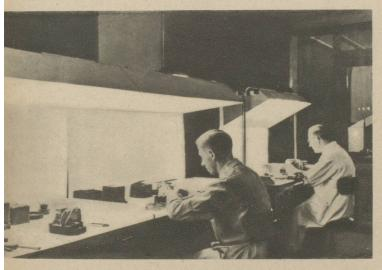
ECLAIRAGE D'UN LABORATOIRE DE MESURES. — Une grande diffusion est nécessaire et est réalisée par la ligne continue d'appareils et par le revêtement blanc placé devant les agents de laboratoire. (Photo Philips.)
