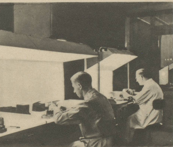
ECLAIRAGE D'UN LABORATOIRE DE MESURES. — Une grande diffusion est nécessaire et est réalisée par la ligne continue d'appareils et par le revêtement blanc placé devant les agents de laboratoire. (Photo Philips.)
