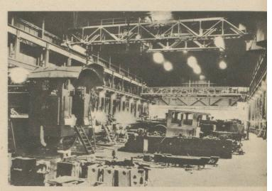
ECLAIRAGE D'UN GRAND HALL DE MONTAGE. — Des foyers puissants, au-dessus du pont roulant, assurent l'éclairage général. Des lignes de foyers le long des poteaux créent la diffusion nécessaire.
