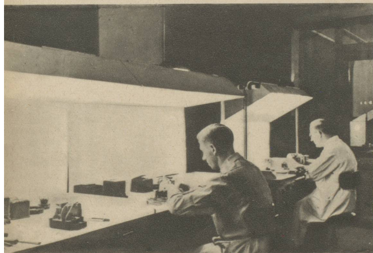
ECLAIRAGE D'UN LABORATOIRE DE MESURES. — Une grande diffusion est nécessaire et est réalisée par la ligne continue d'appareils et par le revêtement blanc placé devant les agents de laboratoire. (Photo Philips.)
