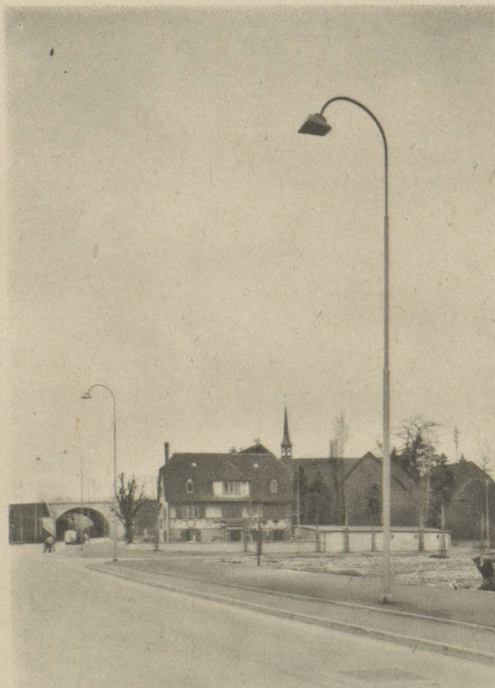
BALE SAINT - JAKOB. — Equipement : lampes à vapeur de sodium 6.500 lm, 105 W. - Hauteur du point lumineux : 9,6 m. - Distance des points lumineux : 28 à 35 m. - Largeur de la route : 8,5 m, avec les trottoirs env. 14 m. - Revêtement de la route : béton. - Photographies de jour et de nuit.
