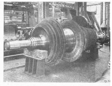
ROTOR DE TURBINE A VAPEUR DE 40.000 KW
