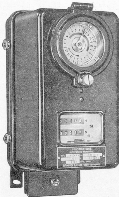
Fig. 1. — Compteur à double tarif avec horloge de commande (Landis et Gyr).
