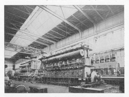
de tels moteurs d'essai doivent avoir de grandes dimensions pour que les expériences ainsi établies puissent, sans autre, être utilisées dans la fabrication de machines commerciales à grande puissance.
