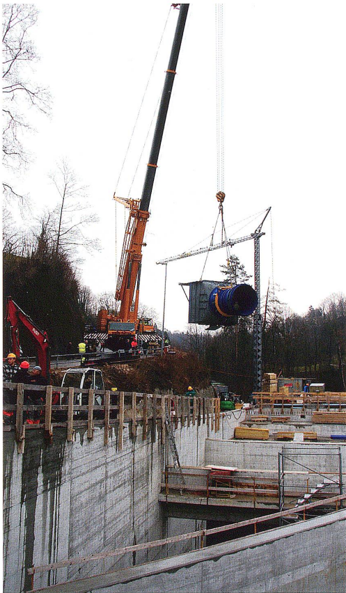
Der Autokran platzierte mit Hilfe der Arbeiter vorsichtig die erste Turbine in der Grube.
