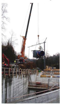
Der Autokran platzierte mit Hilfe der Arbeiter vorsichtig die erste Turbine in der Grube.
