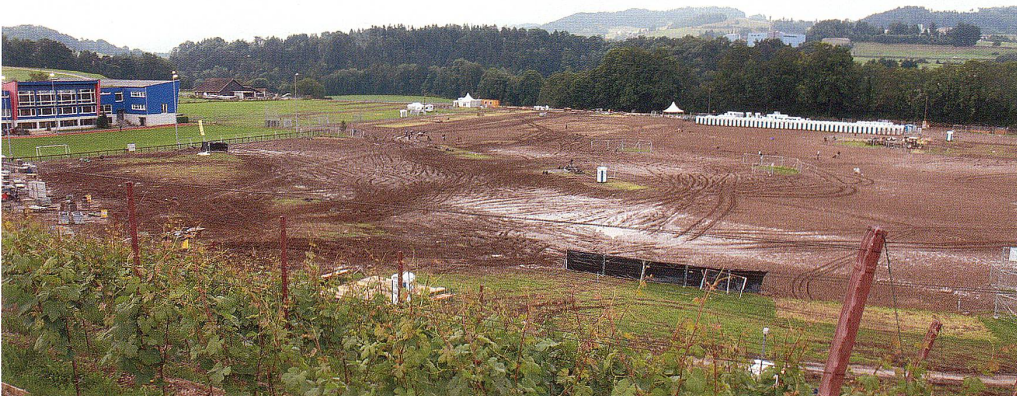
...und fertig ist die Schlammhalde: Als wäre ein Sturm über die Degenau gefegt.
