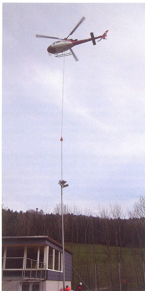
Die neuen Lichtmasten werden mit dem Helikopter versetzt.
