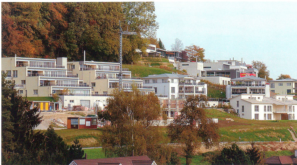
Im Gebiet Lenter in Zuzwil entsteht eine neue Siedlung.
