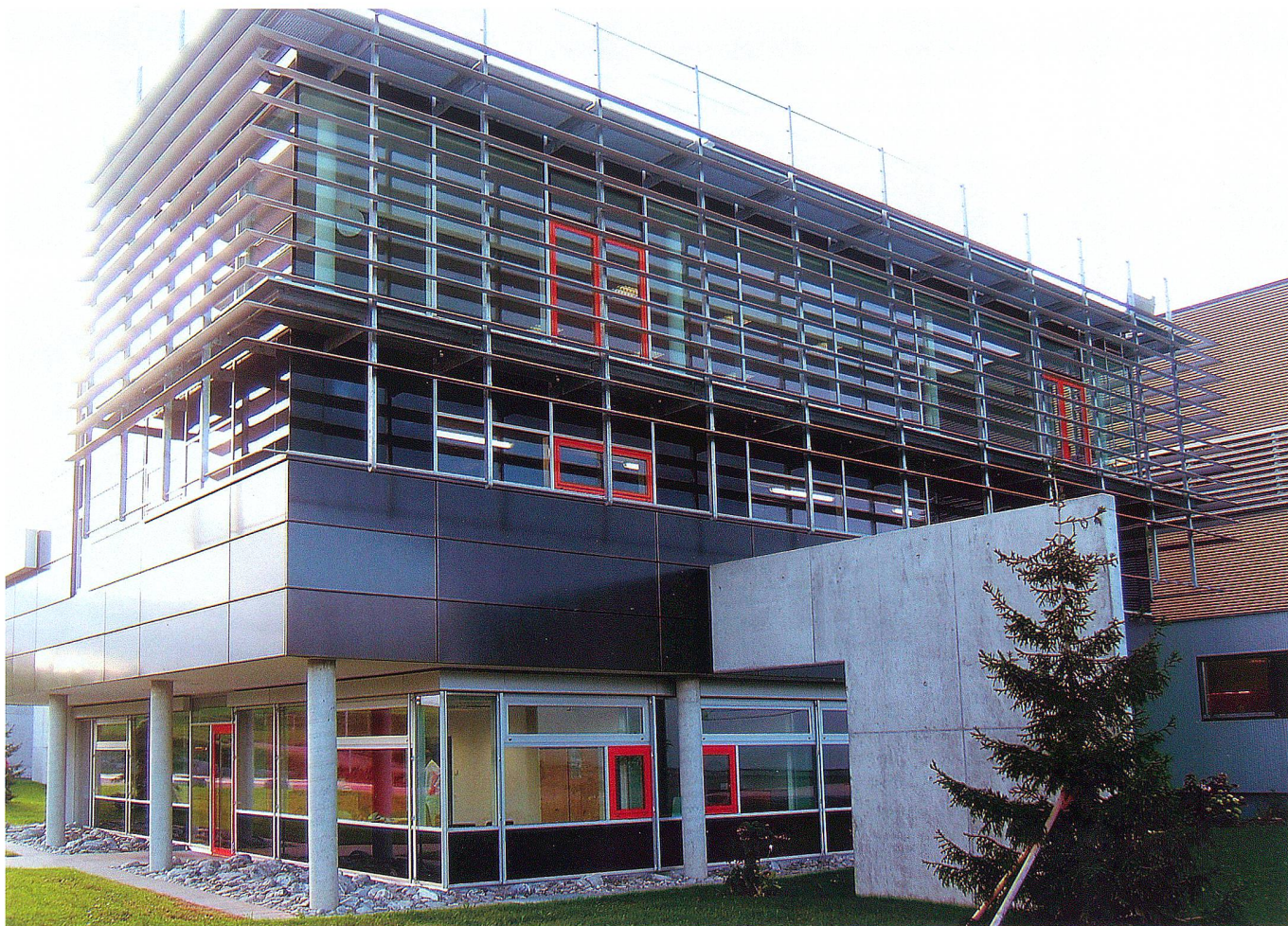
Der Neubau des Schlachthofes der SBAG in Bazenhaid.
