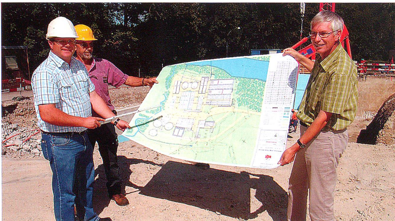
Ingenieur Roland Boller, Klärmeister Jakob Rütthemann und Gemeindepräsident Christoph Häne orientieren über den Bauverlauf der dritten Etappe Ara Bazenheim.
