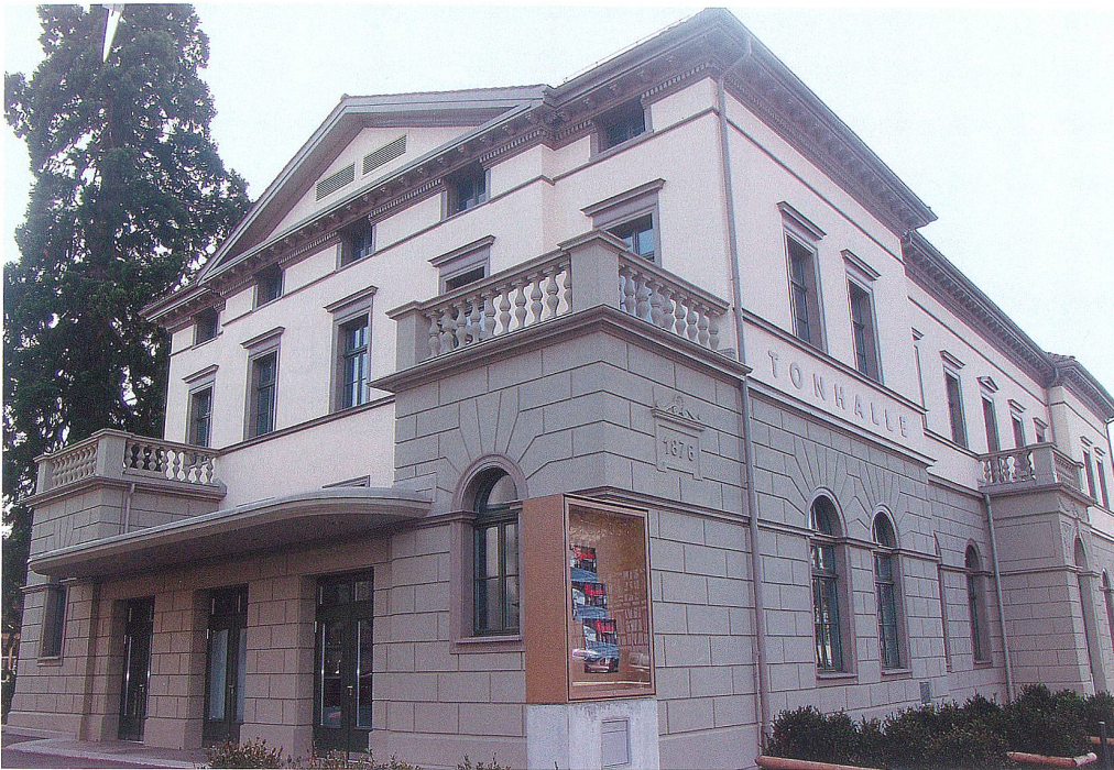
Die Tonhalle Wil erstrahlt in neuem Glanz.
