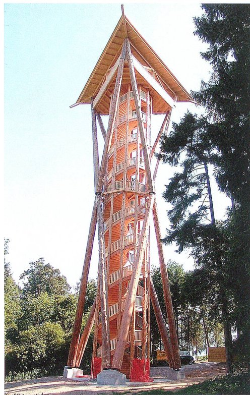
Der fertige Turm wartet auf seine «Erstbesteigung».
