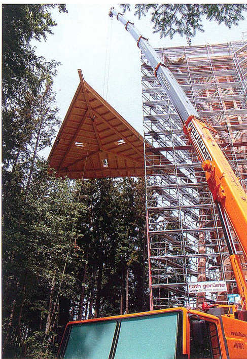
Ein Autokran hievt das 7,5 Tonnen schwere Dach auf eine Höhe von rund 36 Metern.
