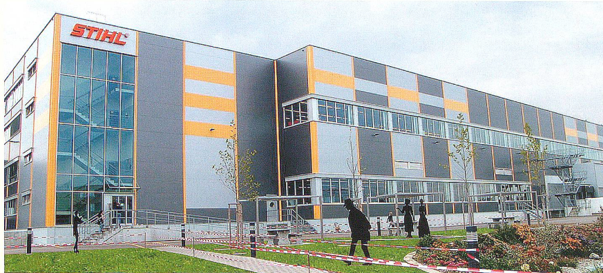
Mit der Fertigstellung des Erweiterungsbaus wurde auch das erste Blockheizkraftwerk bei STIHL & Co. in Betrieb genommen.
