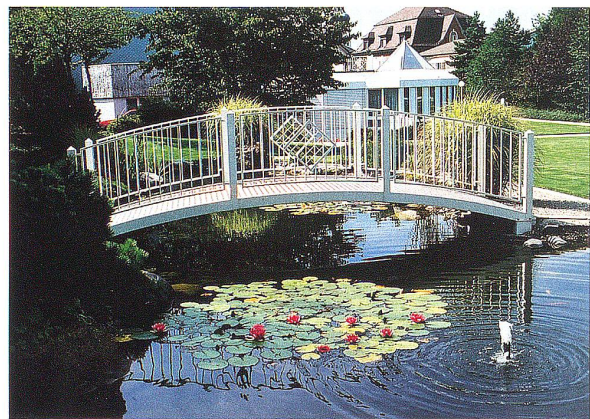
Brücke mit Geländer – gefertigt in unserer Schlosserei.
