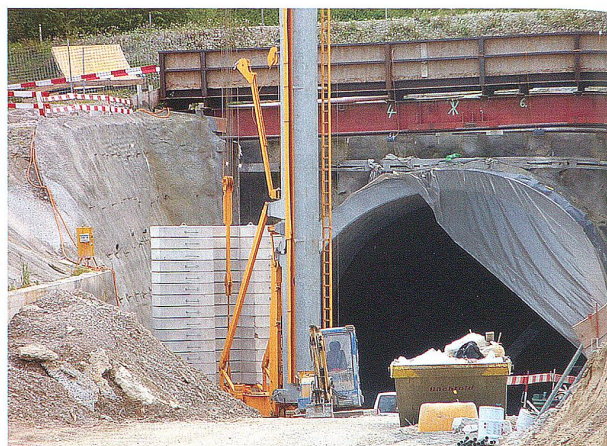
Die Umfahrung Bazenheid soll im Spätherbst 2006 abgeschlossen werden.
