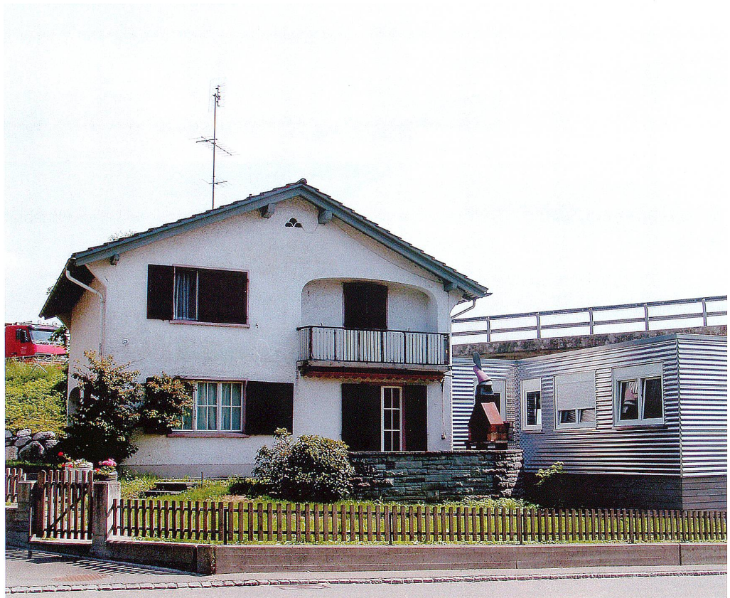
Der Anbau wurde innerhalb von zwei Monaten erstellt und kostete 196 000 Franken.
