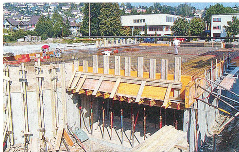
Das Mehrfamilienhaus an der Bronschhoferstrasse mit 10 Eigentumswohnungen und einer Tiefgarage kann Ende April 2006 bezogen werden.
