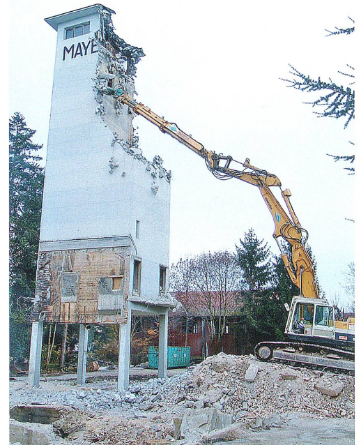
Vorsichtig bricht der Bagger Stück für Stück aus dem Turm heraus.
