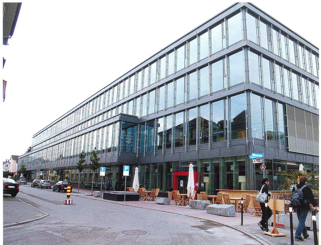
Das neue Railcenter, unmittelbar beim Bahnhof Wil.
