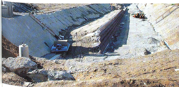
Die Bauarbeiten der Umfahrung Bazenheid mit Wihaldentunnel sollen bis Ende 2006 abgeschlossen sein.
