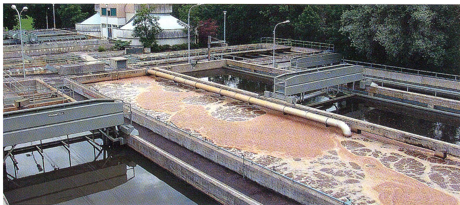
Dieser ARA-Teil wird dann in der 3. Etappe saniert und ausgebaut.
