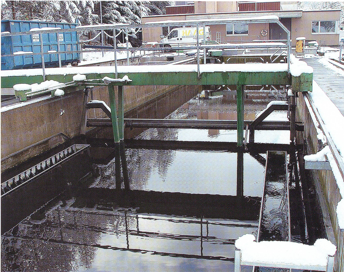
Die erste Bau-Etappe konnte erfolgreich abgeschlossen werden.
